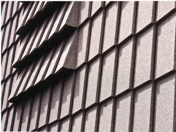
El edificio en su entorno. Detalle de las losas de granito solapadas. Anclaje de las placas al muro. The building in its environment. Detail of the overlapped granite slabs. Anchoring wall plates.
